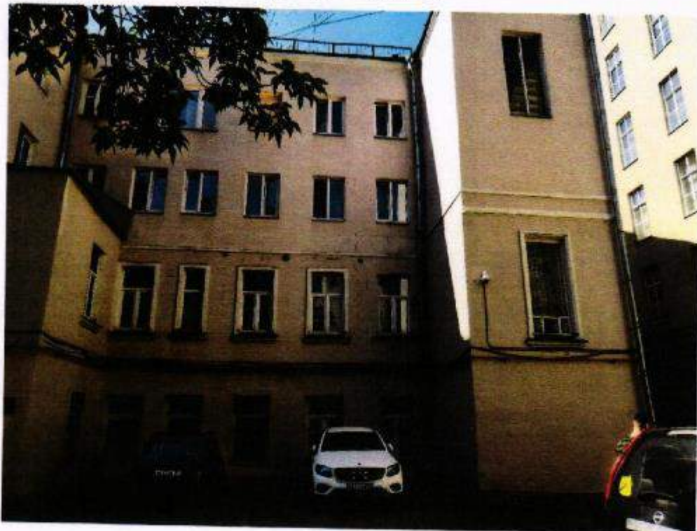
Фото № 4. Вид на дворовый фасад.
