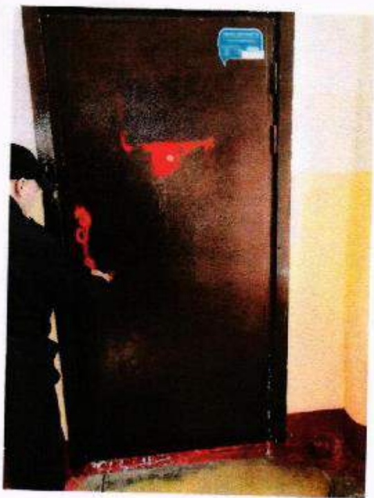
Фото № 7. Вход в помещение I. 2 этаж.
