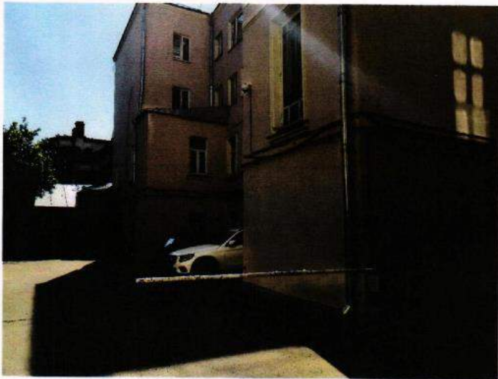
Фото № 5. Вид на дворовый фасад.
