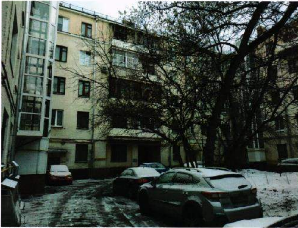
Фото №1 Вид части фасада объекта.
