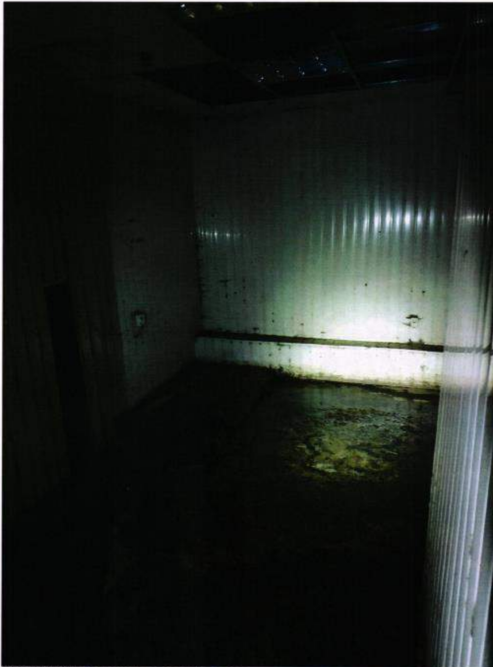
Фото № 5. Вид внутренних помещений подвала.
