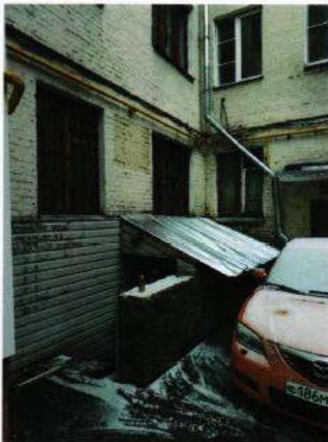
Фото 2. Вид входа в помещение подвала.
