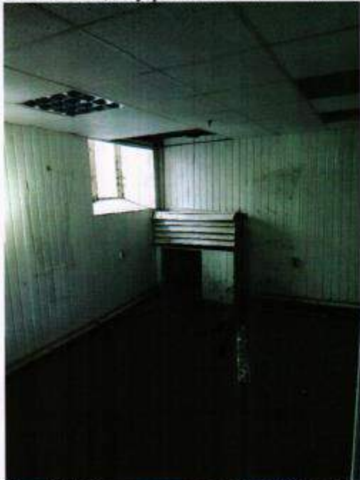
Фото № 4. Вид внутренних помещений подвала.
