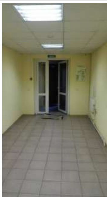
Фото 7.14. Общий вид части помещения.
