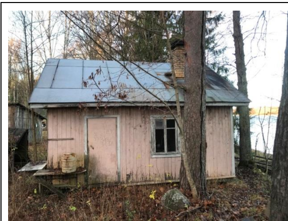
ФОТО № 25. Вид здания столовой щитовой
