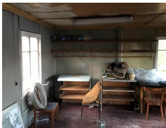
ФОТО № 26. Вид внутри здания столовой щитовой
