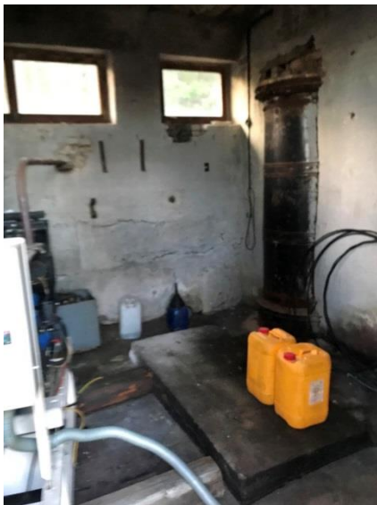
ФОТО № 23. Вид внутри здания производственного корпуса
