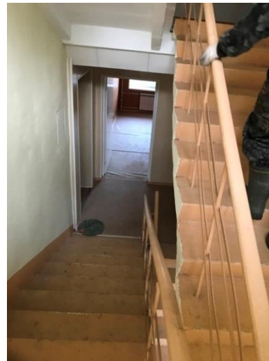
ФОТО № 10. Вид внутри здания бытового корпуса
