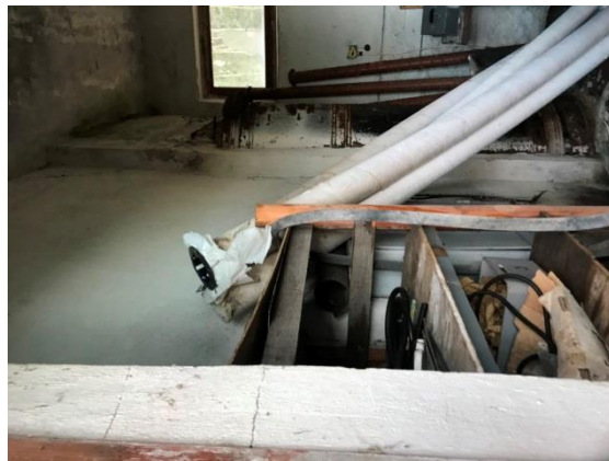
ФОТО № 22. Вид внутри здания производственного корпуса
