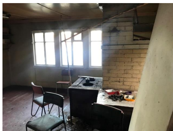
ФОТО № 27. Вид внутри здания столовой щитовой
