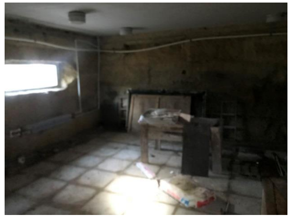
ФОТО № 16. Вид внутри здания бытового корпуса
