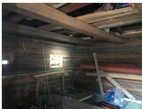
ФОТО № 30. Вид внутри здания бани рубленной
