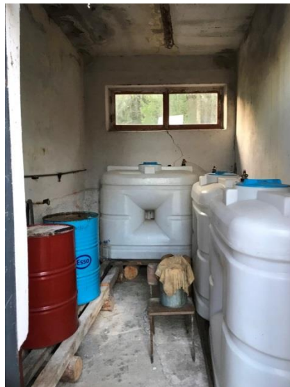
ФОТО № 24. Вид внутри здания производственного корпуса
