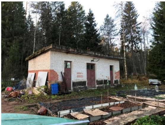
ФОТО № 21. Вид здания производственного корпуса
