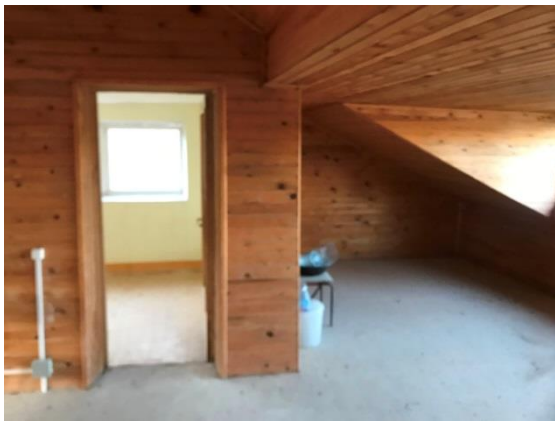
ФОТО № 15. Вид внутри здания бытового корпуса
