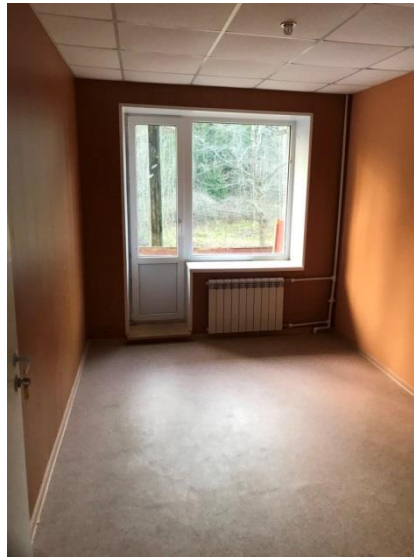
ФОТО № 8. Вид внутри здания бытового корпуса
