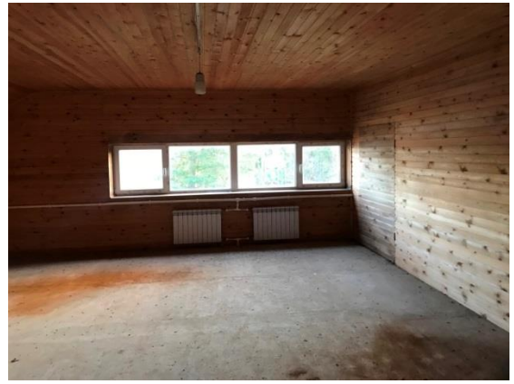
ФОТО № 14. Вид внутри здания бытового корпуса
