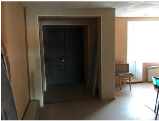
ФОТО № 19. Вид внутри здания бытового корпуса
