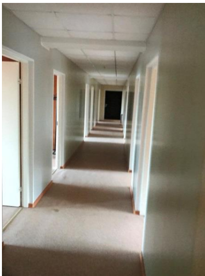
ФОТО № 11. Вид внутри здания бытового корпуса
