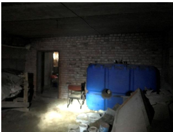
ФОТО № 17. Вид внутри здания бытового корпуса
