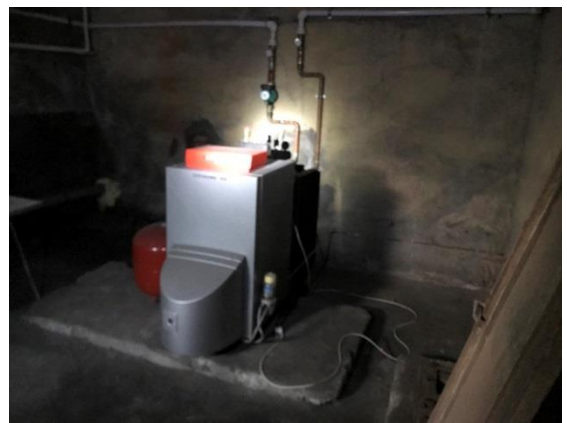
ФОТО № 18. Вид внутри здания бытового корпуса
