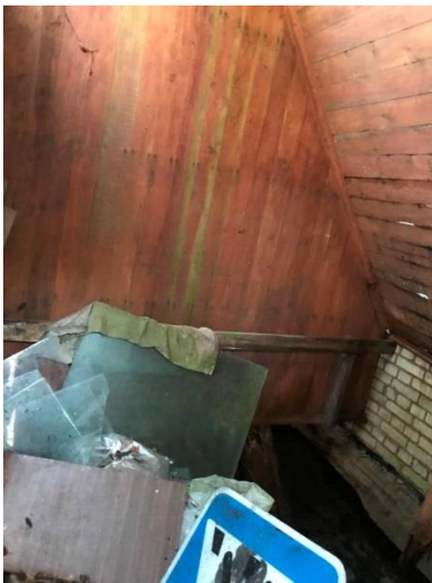
ФОТО № 33. Вид внутри сооружения санитарного узла
