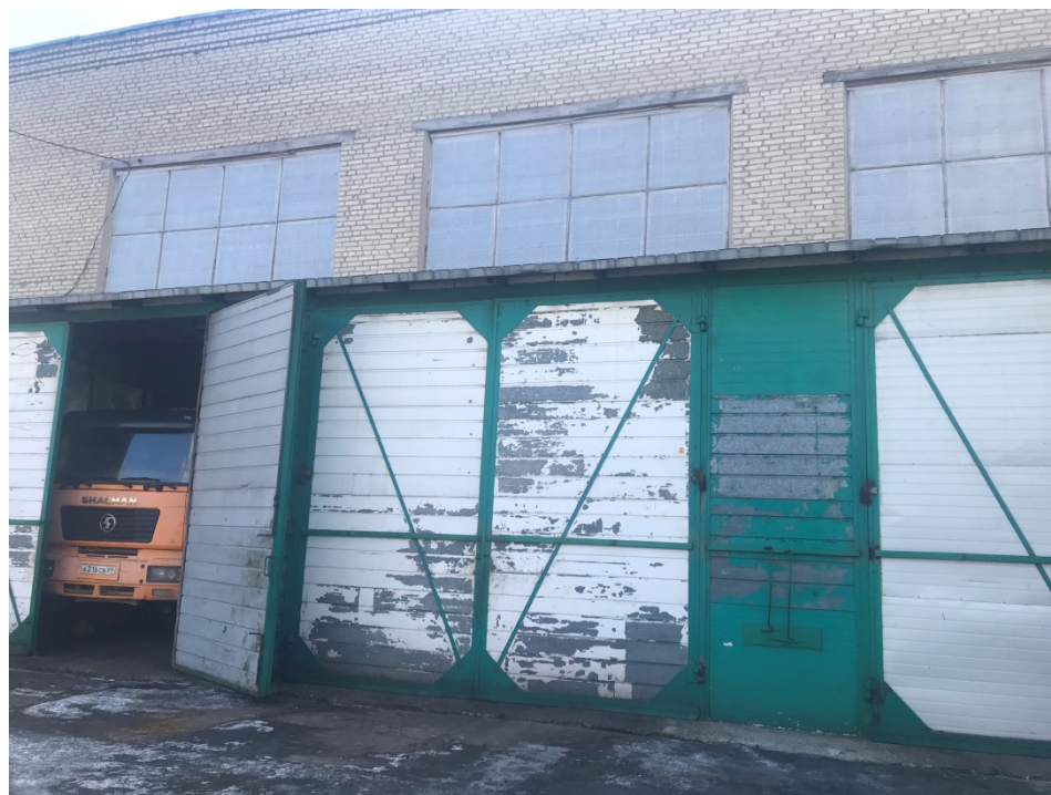
Нежилое здание (ремонтно-механический цех)
