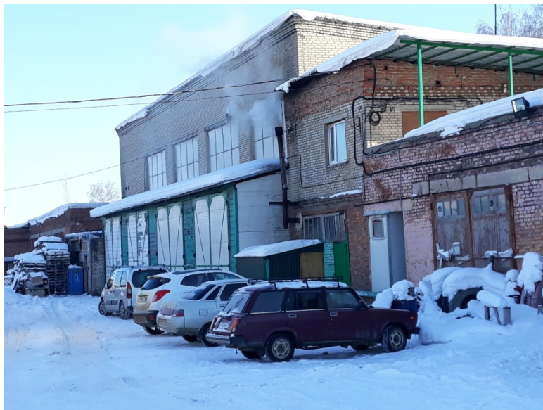
Здание склада материального
