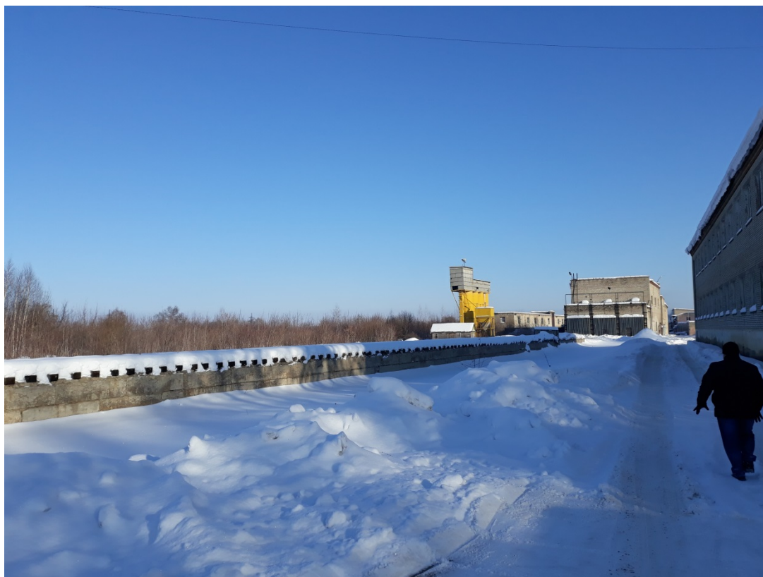
Сооружение (путь подъездной железнодорожной широкой колеи)
