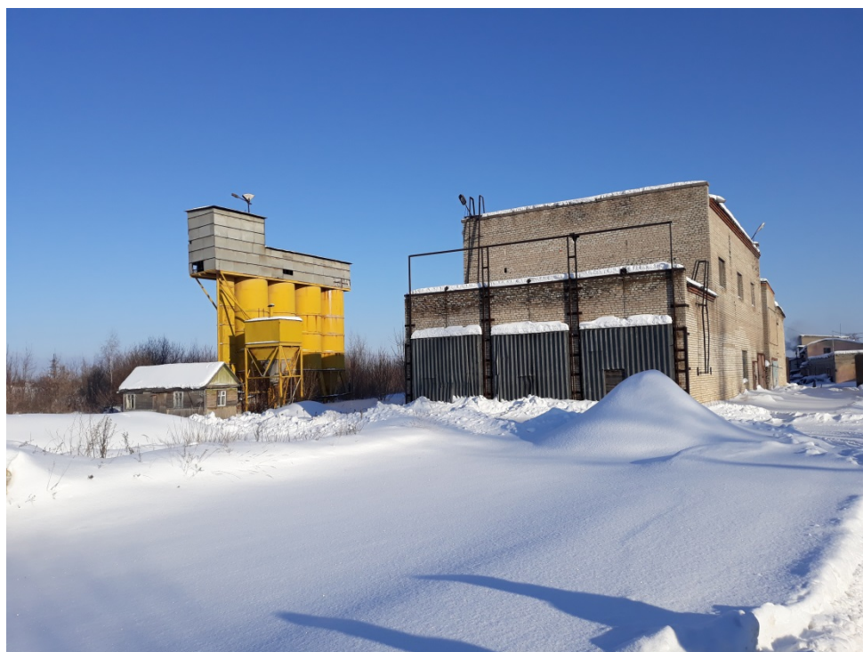
Сооружение (склад для цемента( металлические емкости)
