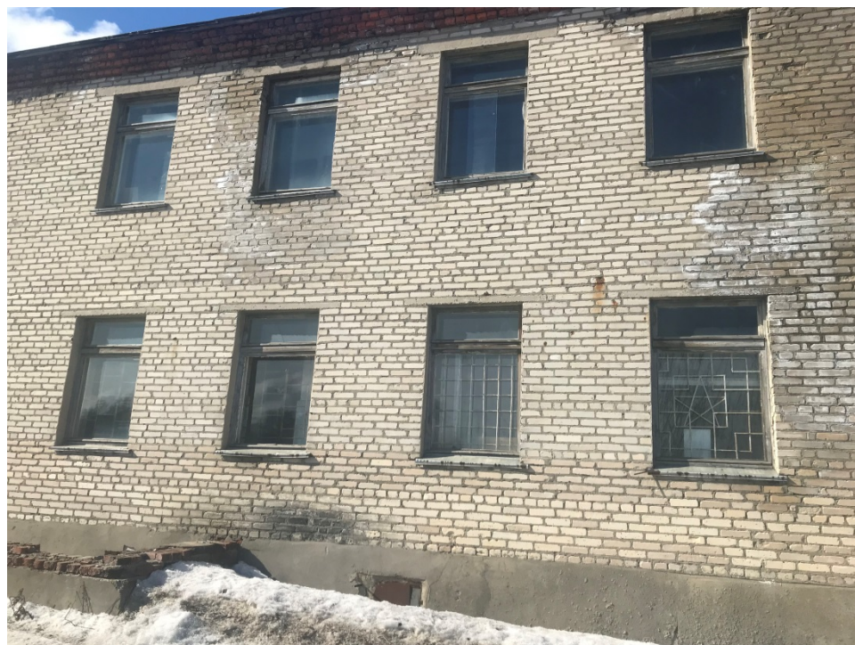
Нежилое здание (столярно-комплектовочный цех)
