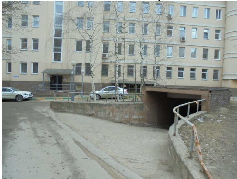
Общий вид дома, въезд
