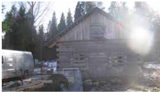
ФОТО № 20. Здание бани рубленной
