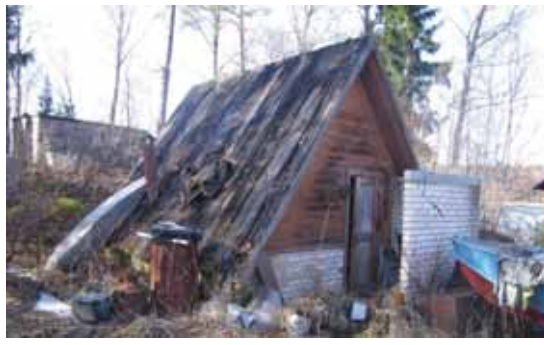
ФОТО № 22. Здание санитарного узла
