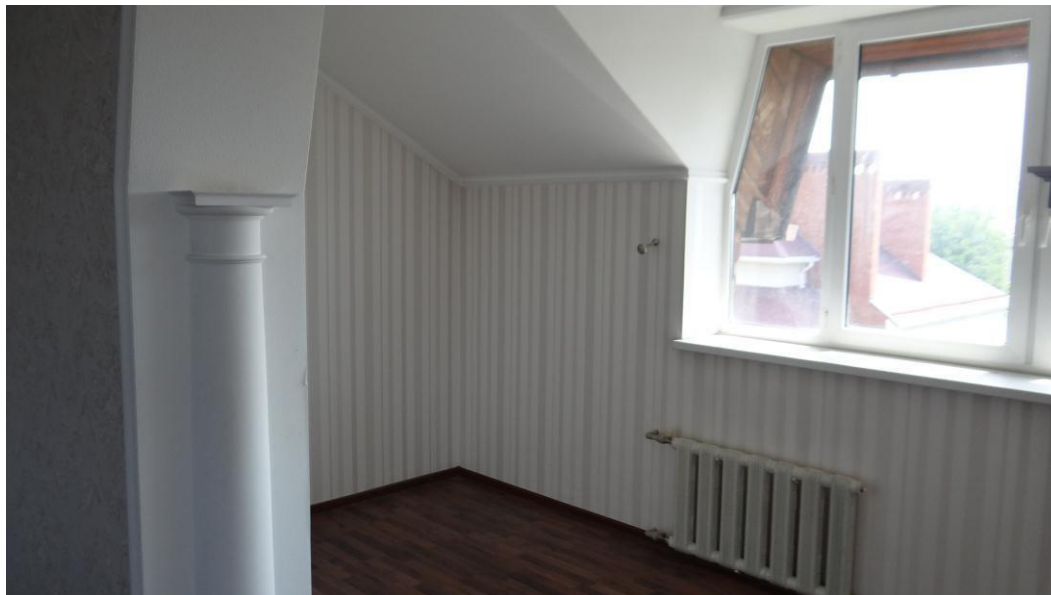
Помещение инв.№27 - лоджия
