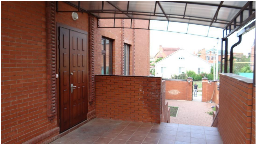
Входная дверь в дом
