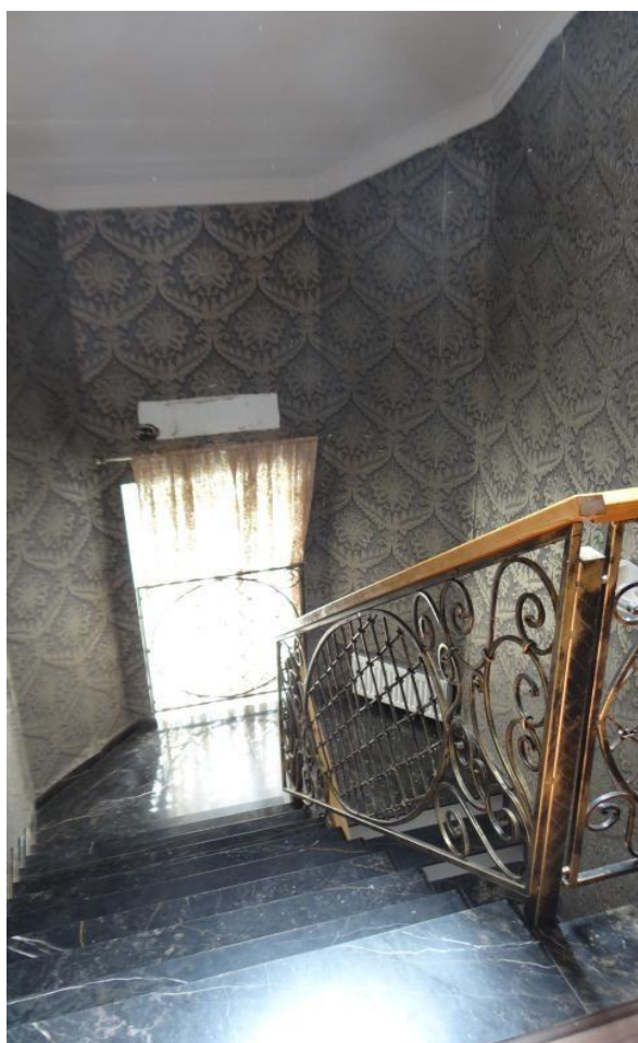
Помещение инв.№26 – лестничная клетка
