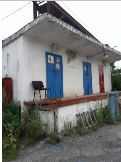
Фото здания проходной, литер Н
