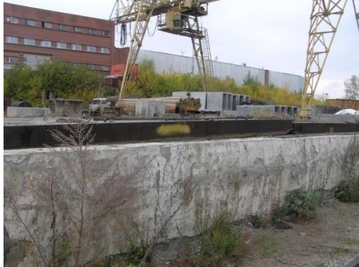
Фото замощенного покрытия территории производственной базы, литер XI, учетные участки 1-4
