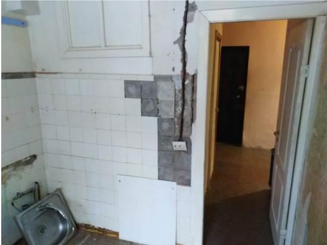
Внутренний вид кухни
