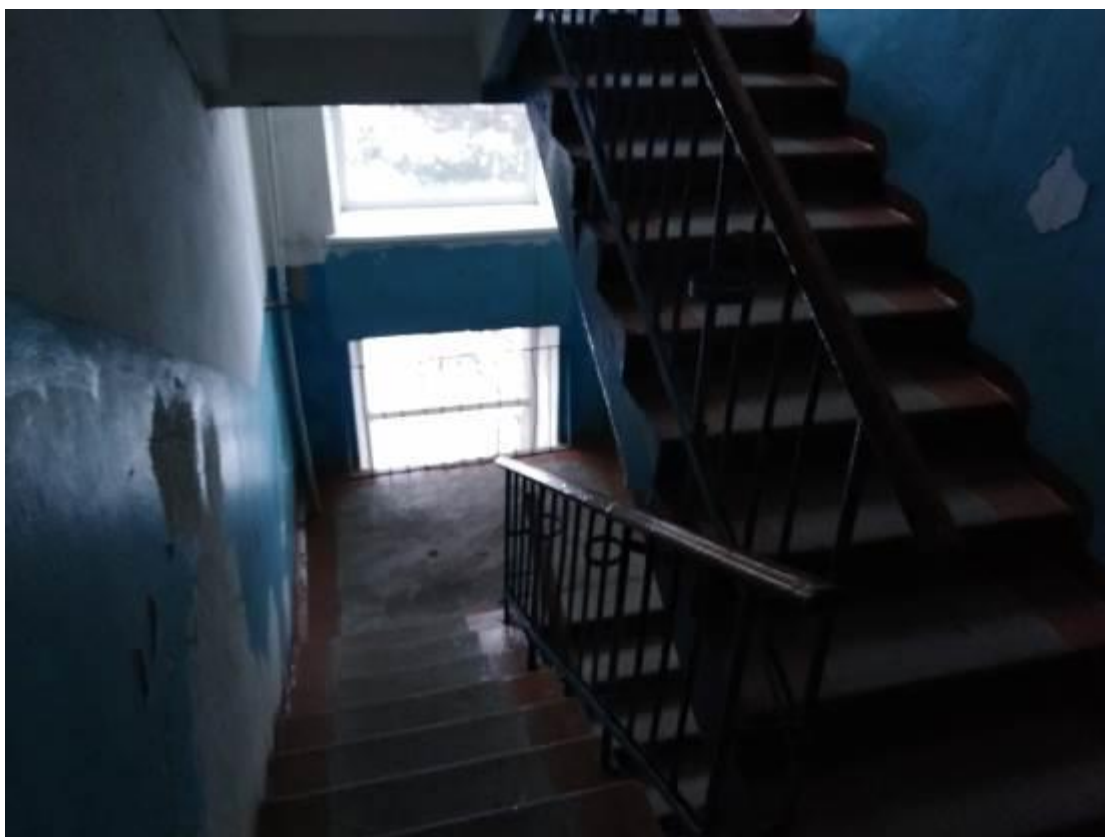
Вид лестничной площадки в подъезде
