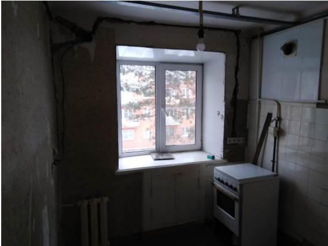
Внутренний вид кухни
