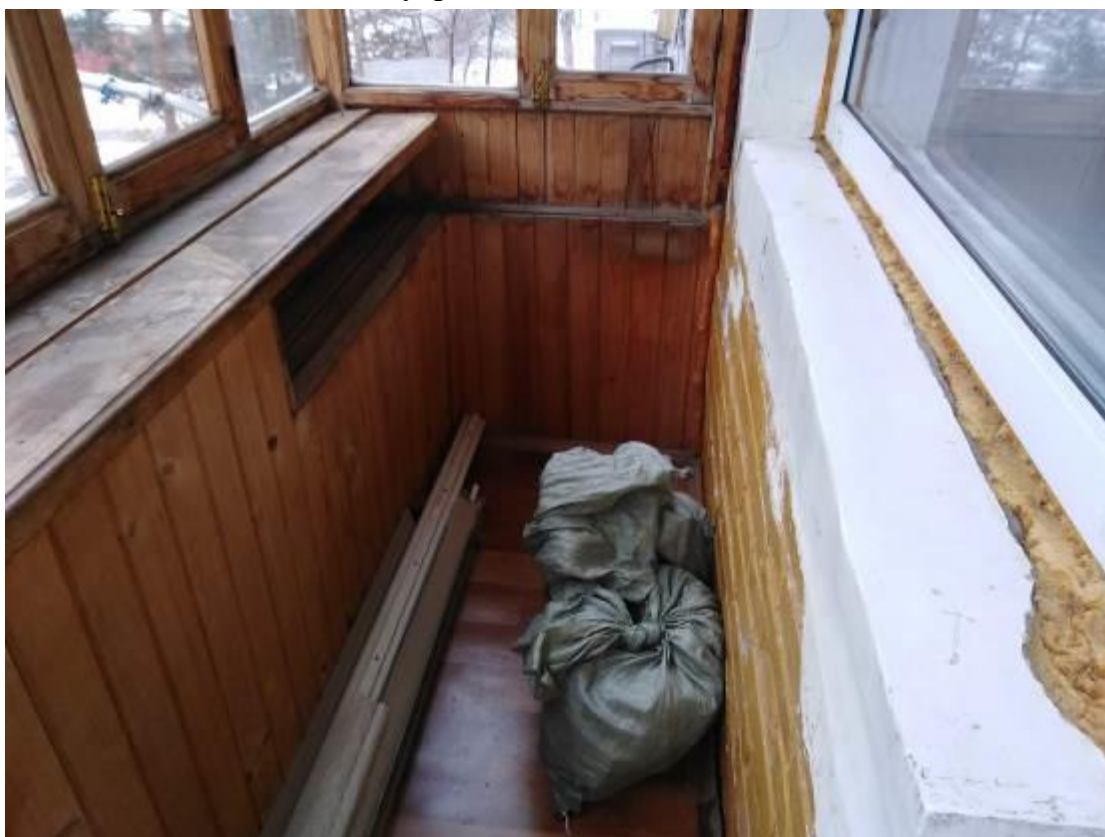
Внутренний вид балкона
