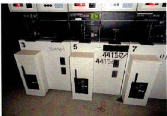
Фотография 3. Распределительные ячейки 10 кВ SM6 - DM1
