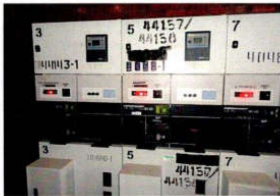
Фотография 2. Распределительные ячейки 10 кВ SM6 - DM1
