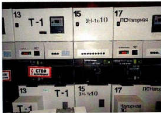
Фотография 4. Распределительные ячейки 10 кВ SM6 - DM1, GAM
