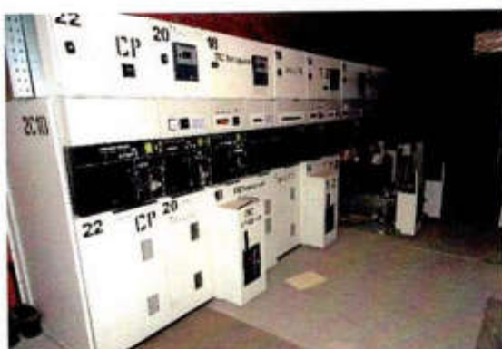
Фотография 5. Распределительные ячейки 10 кВ SM6 - IM, CM, DM1
