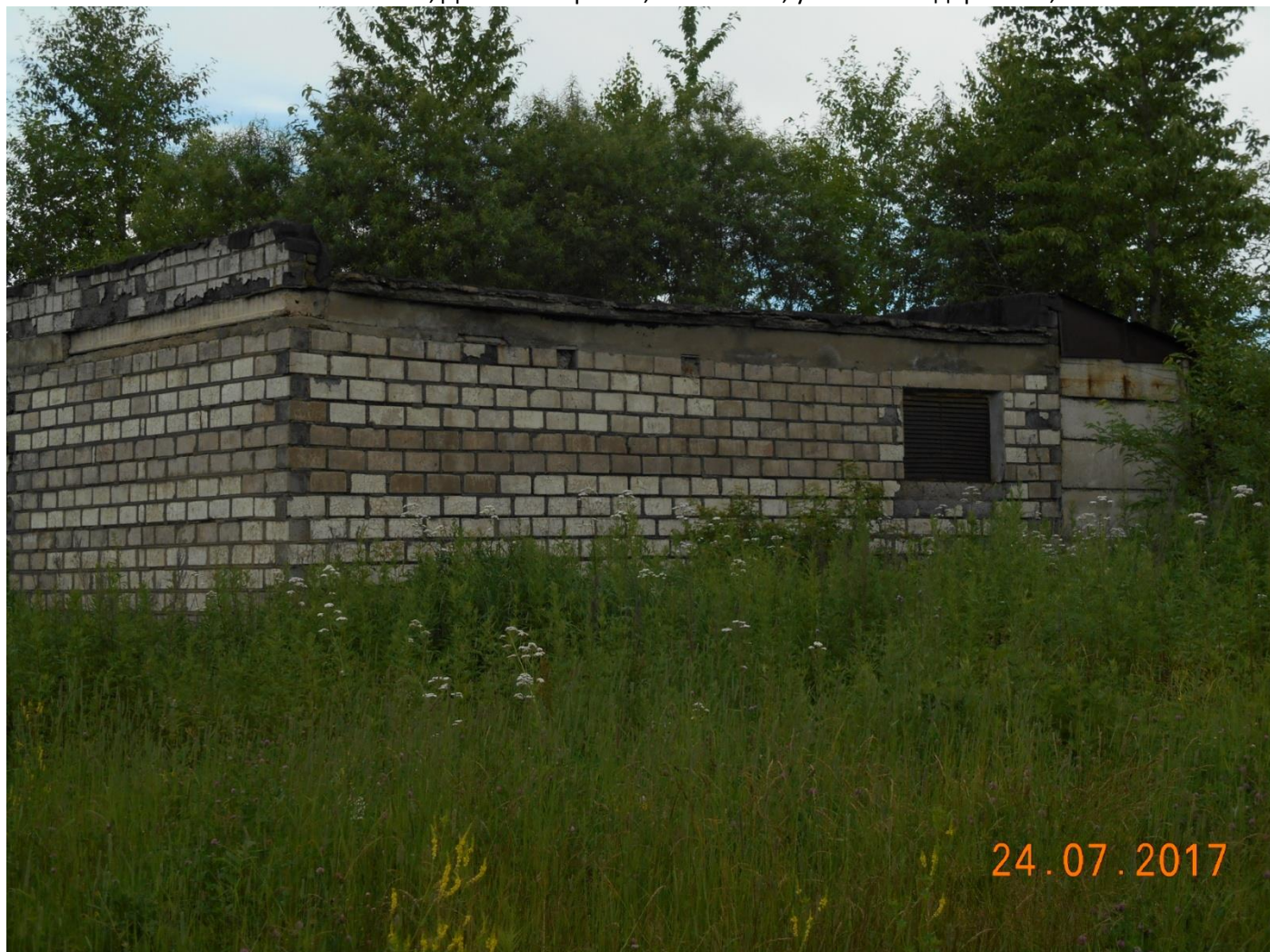
12) Трансформаторная подстанция (59,8 кв.м.)
