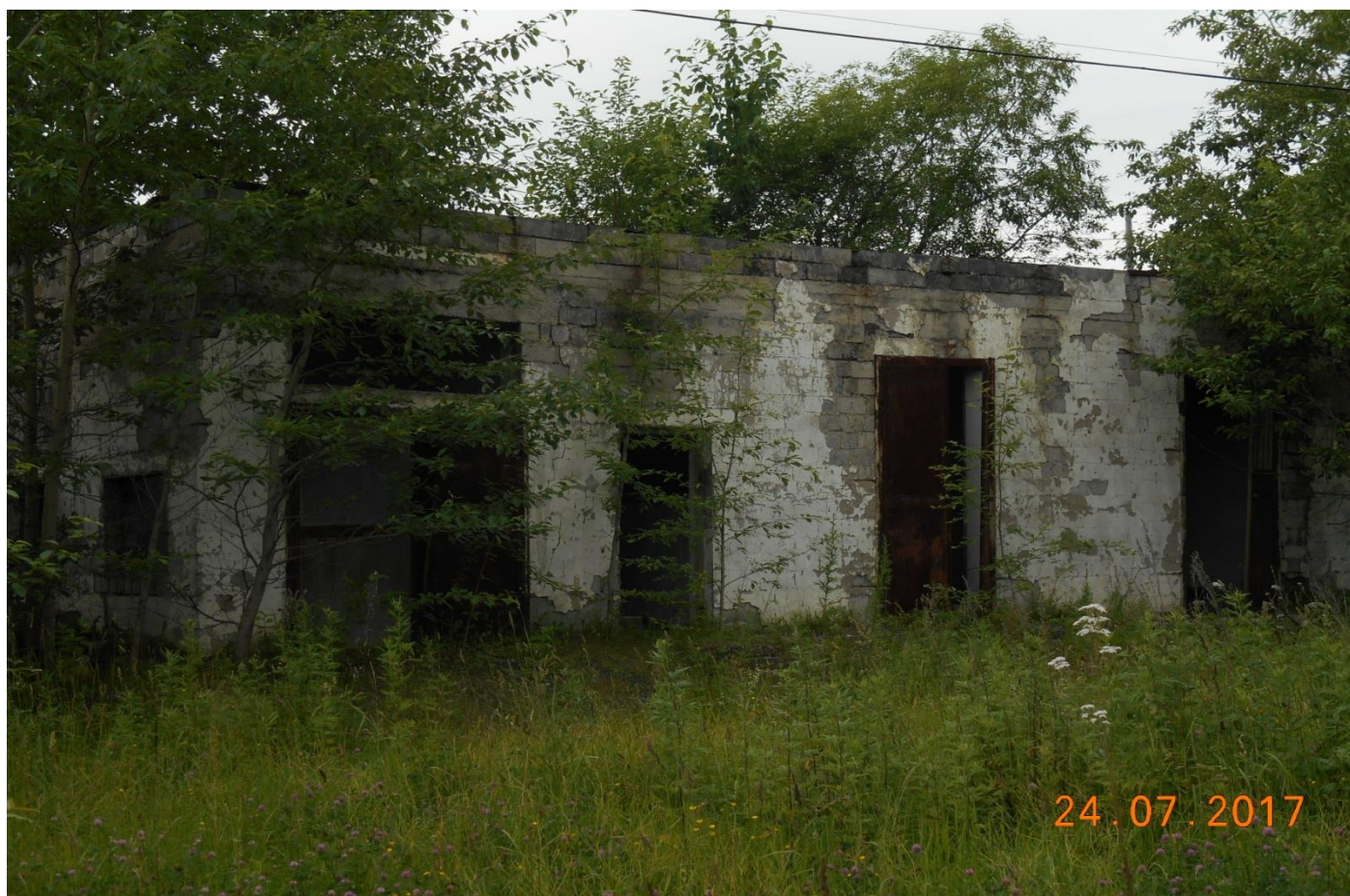
7) Трансформаторная подстанция (без оборудования) (104,6 кв.м.)
