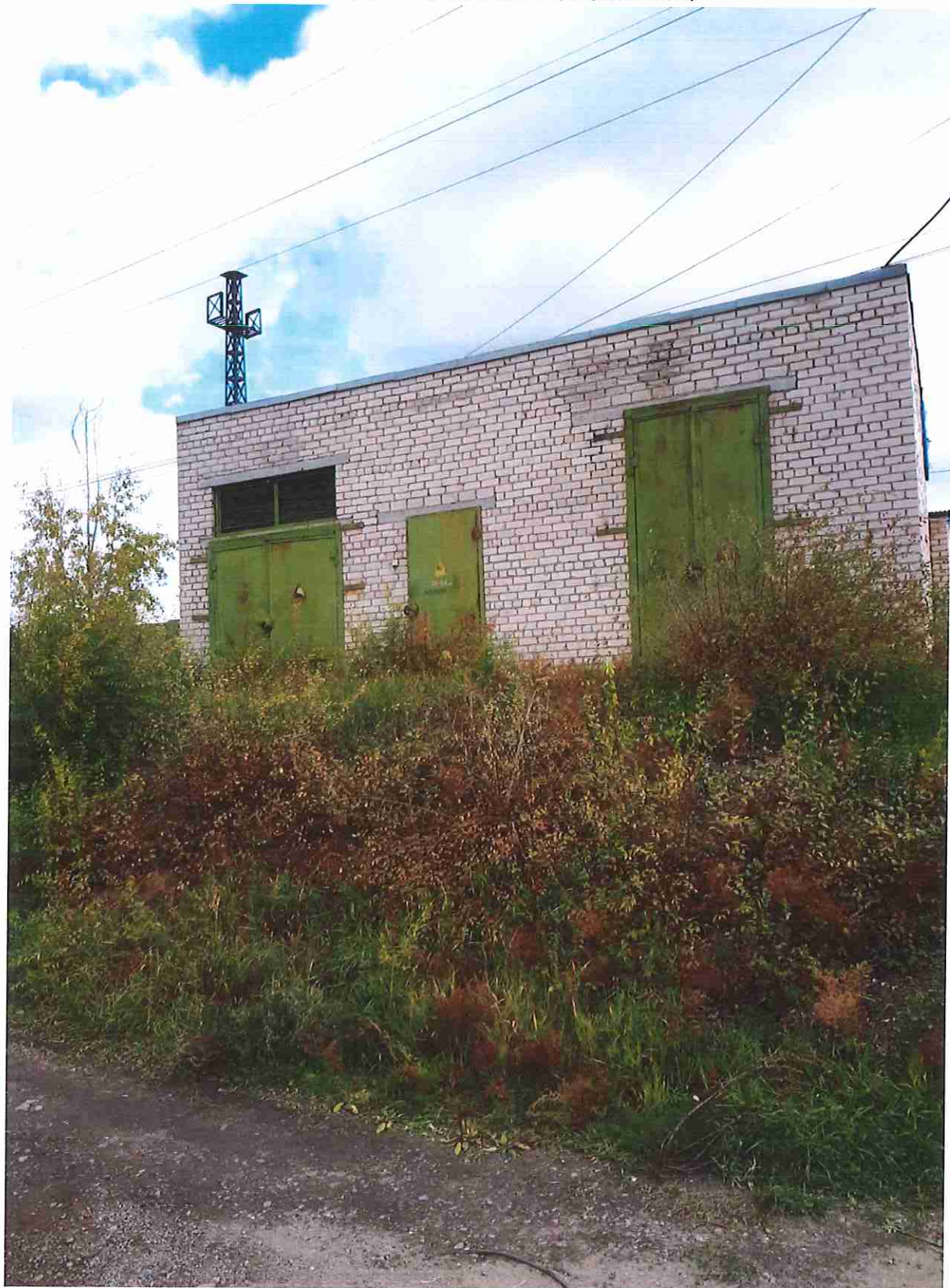
9. Трансформаторная подстанция (53, 3 кв.м.)
