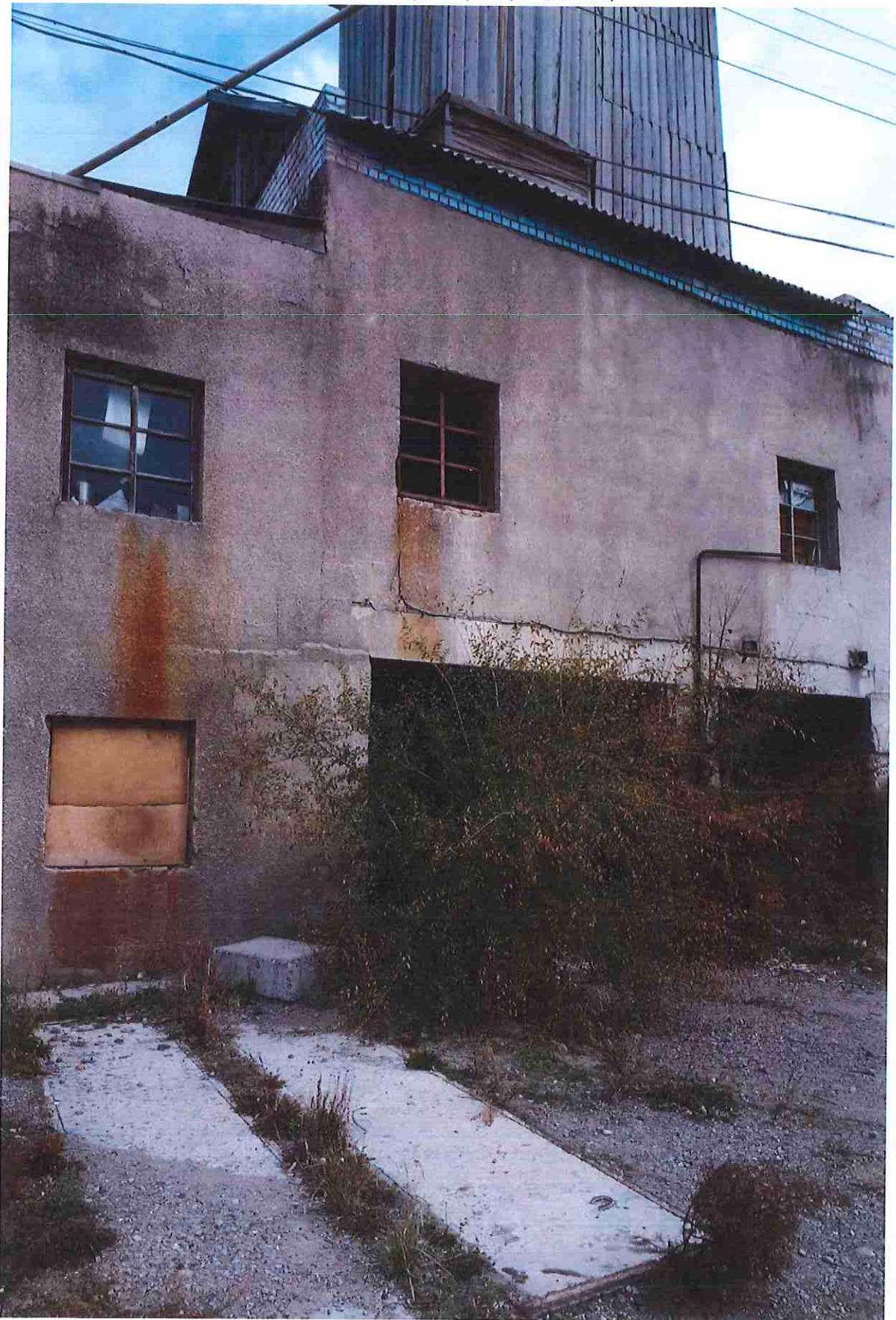
10. Бетонорастворный узел (195,6 кв.м.)
