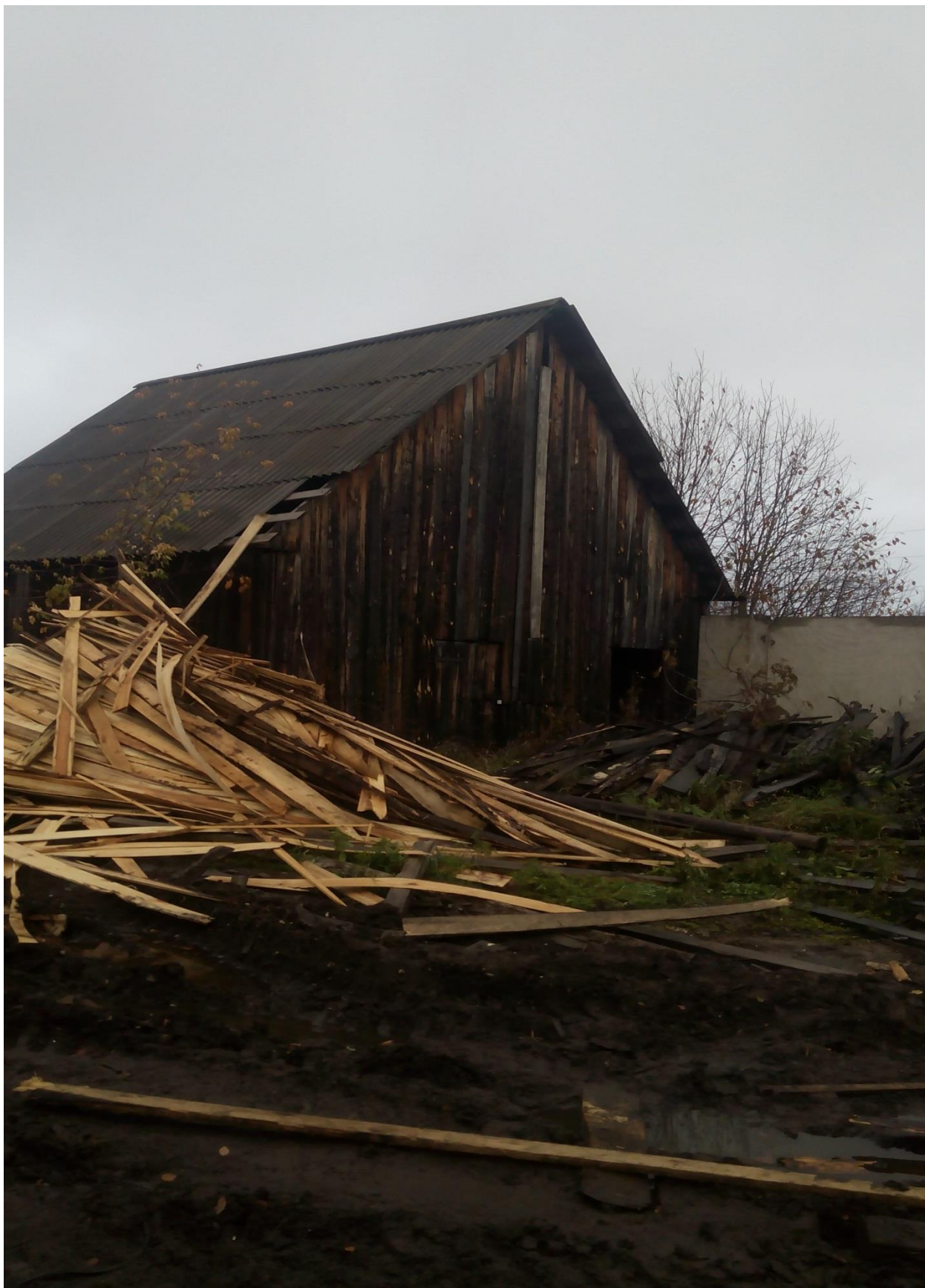
Здание лесопильного цеха, лит. В
