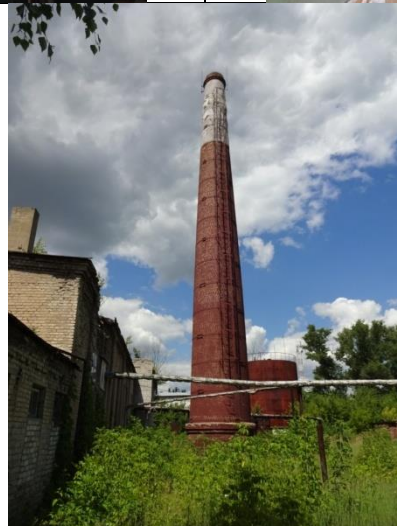
Фото здания склада цемента, лит. Т, под Т
