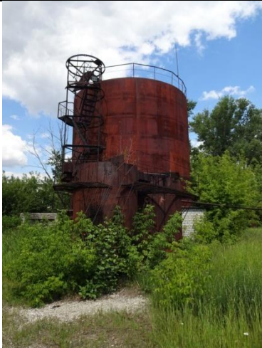
Фото резервуара металлического для топливного мазута
