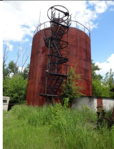
Фото резервуара металлического для топливного мазута
