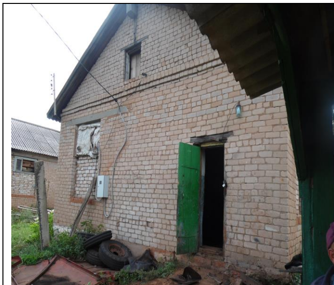
Внешний вид нежилого здания
