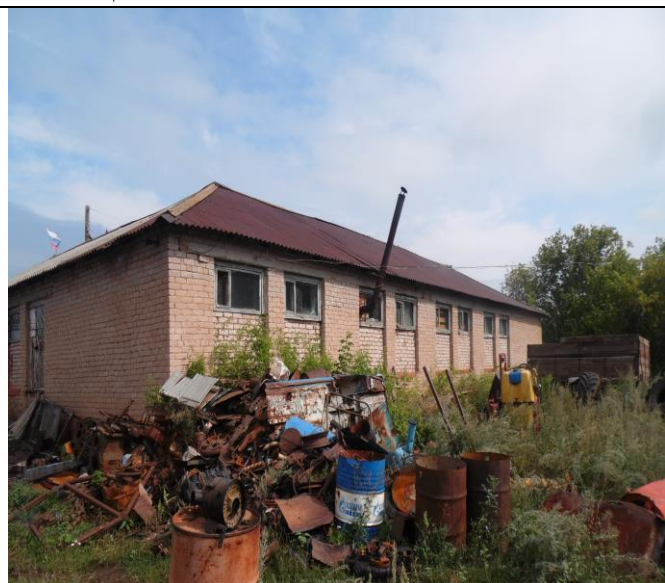
Внешний вид нежилого здания
