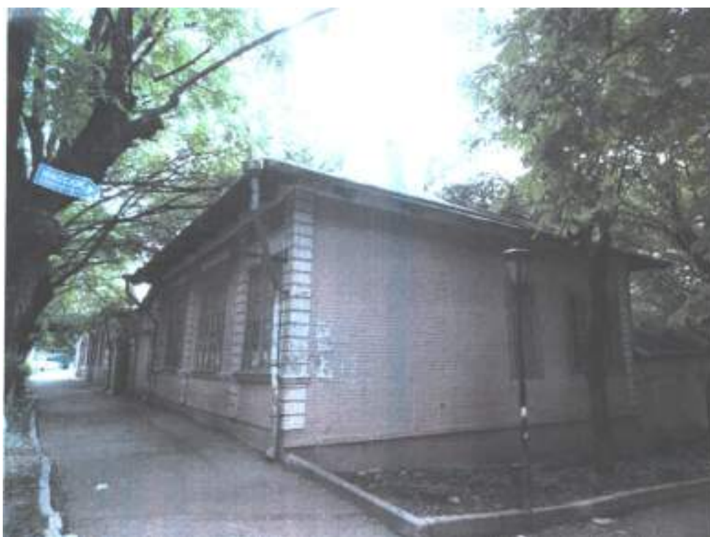
Фото 11. Объект культурного наследия федерального значения «Подворье Карловых, где Лермонтов Михаил Юрьевич провел последнюю ночь перед дуэлью», 1841 г., Ставропольский край, г. Железноводск, ул. Семашко, 9/11. Главный и боковой фасады (литер В).
