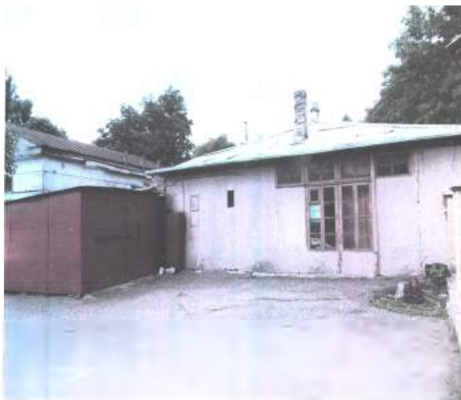
Фото 23. Объект культурного наследия федерального значения «Подворье Карповых, где Лермонтов Михаил Юрьевич провел последнюю ночь перед дуэлью», 1841 г., Ставропольский край, г. Железноводск, ул. Семашко, 9/11. Восточный фасад (литер Г)
