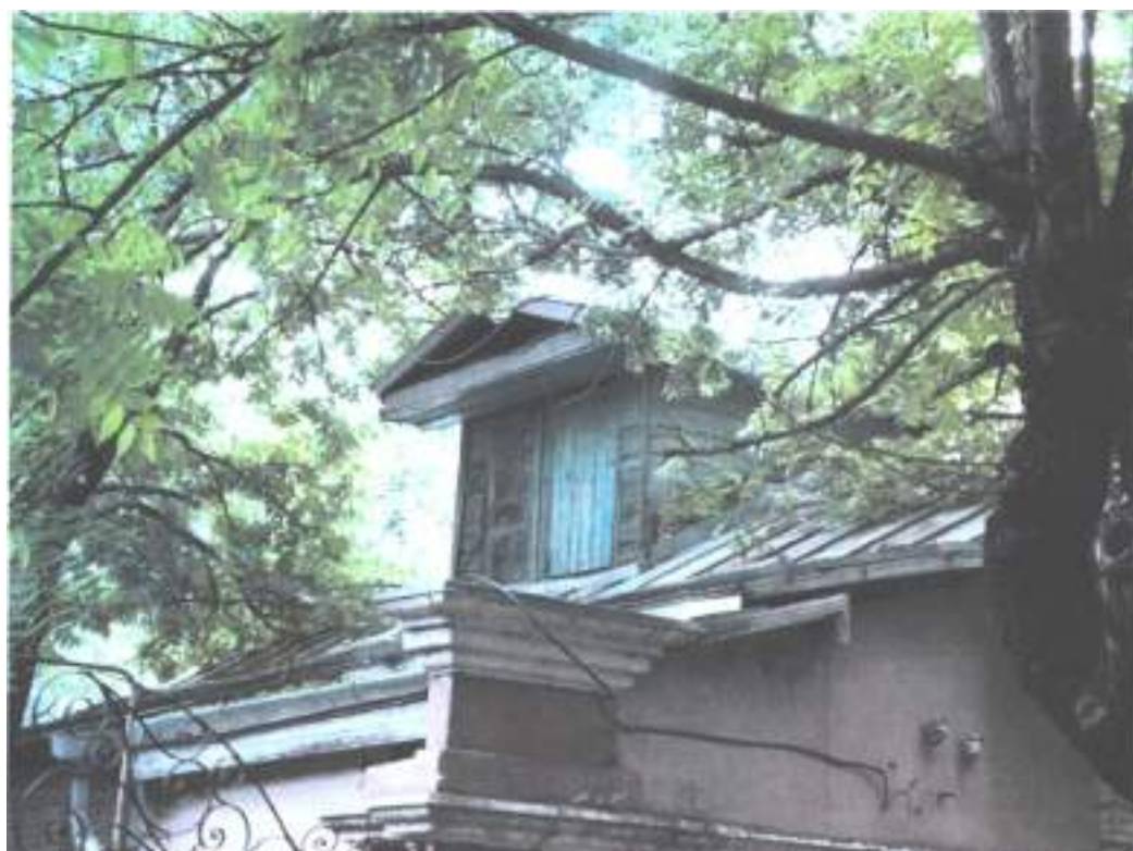
Фото 13. Объект культурного наследия федерального значения «Подворье Карновых, где Лермонтов Михаил Юрьевич провел последнюю ночь перед дуэлью», 1841 г., Ставропольский край, г. Железноводск, ул. Семашко, 9/11 Фрагмент кровли (литер В).
